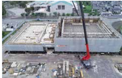
躯体工事施工状況
