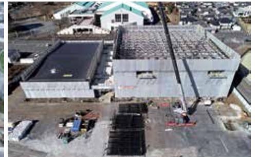
鉄骨・屋根施工状況
