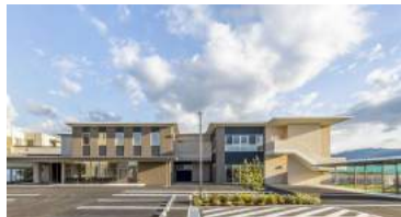
高齢者総合福祉施設 おきなのだ 所在地: 奈良県北葛城郡広陵町 構造・階数: RC(-部S)造・2階 延床面積: 2,617㎡
