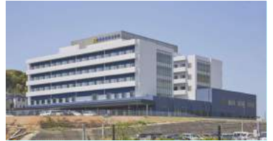
長崎北徳洲会病院 所在地: 長崎県西彼杵郡長与町 構造・階数: RC造・6階 延床面積: 12,705㎡【108床】
