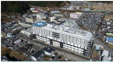
島田市立総合医療センター 所在地: 静岡県島田市野田 構造・階数: S(鉄)造・8階/B1階 延床面積: 38,289㎡【445床】
