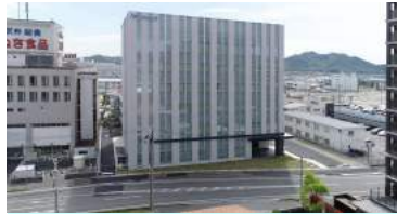
美樹工業株式会社 本社ビル 所在地: 兵庫県姫路市北条 構造・階数: S造・6階 延床面積: 7,969㎡
