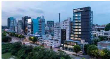
市ヶ谷科学技術イノベーションセンタービル 所在地: 東京都新宿区市谷町 構造・階数: S造・12階 延床面積: 2,021㎡
