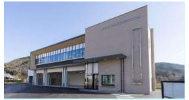
能勢町消防庁舎 所在地: 大阪府豊能郡能勢町 構造・階数: RC造・2階 延床面積: 984㎡
