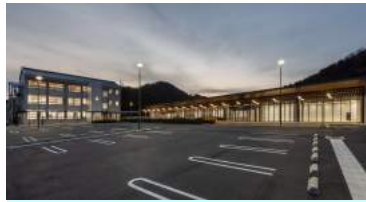
能勢町庁舎 所在地: 大阪府豊能郡能勢町 構造・階数: S造・1階、RC造・3階 延床面積: 1,494㎡、814㎡
