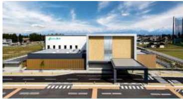
双星会 みなみの星病院 所在地: 富山県富山市二俣 構造・階数: S造・3階 延床面積: 3,660㎡【40床】
