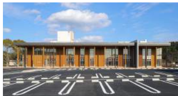
南関町庁舎 所在地: 熊本県玉名郡南関町 構造・階数: W造・2階(改修: RC造・3階) 延床面積: 1,406㎡(改修: 4,897㎡)
