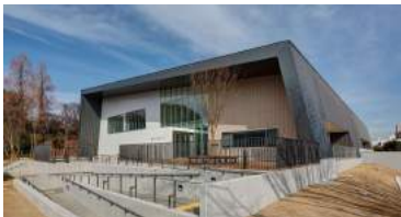
豊中市立ニノ切温水プール 所在地: 大阪府豊中市 構造・階数: S(-部RC)造・2階/B1階 延床面積: 2,739㎡
