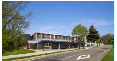
札幌南徳洲会病院 所在地: 北海道札幌市清田区平岡 構造・階数: RC(-部S)造・2階/B1階 延床面積: 7,167㎡【88床・人工透析25床】
